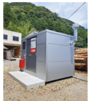
防災燃油倉庫
